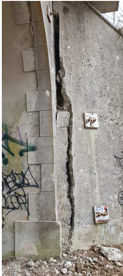
Particolare spanciamento muro andatore lato nord della spalla
